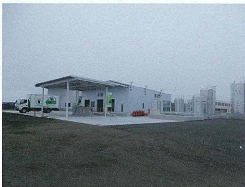
平成28年3月に移転した新工場
